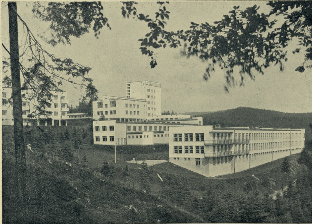
OGÓLNY WIDOK ZAKŁADU.
