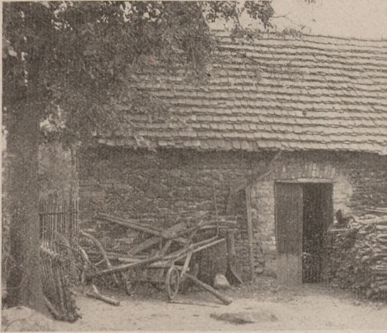
Auch aus Rasenerzsteinen wurden früher Häuser gebaut. Wir sehen hier die alte Dorfschmiede in Lössen
