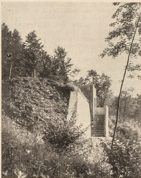
Wasserbehälter der Wasserleitung im Seiffental
