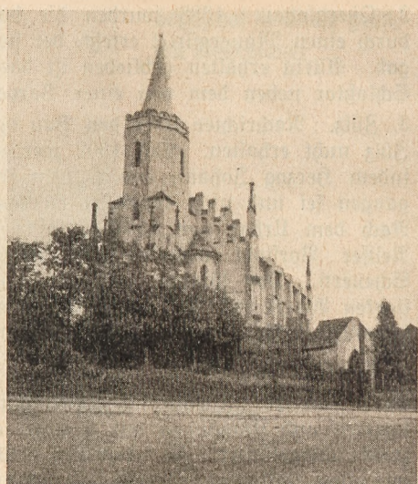
Kath. Pfarrkirche, Dittersdorf OS.
