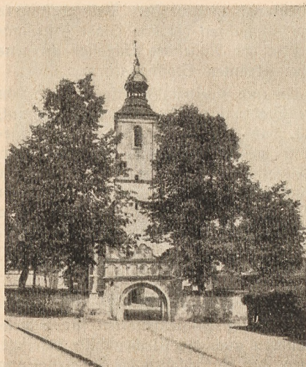
Kath. Pfarrkirche in Kujau OS.
