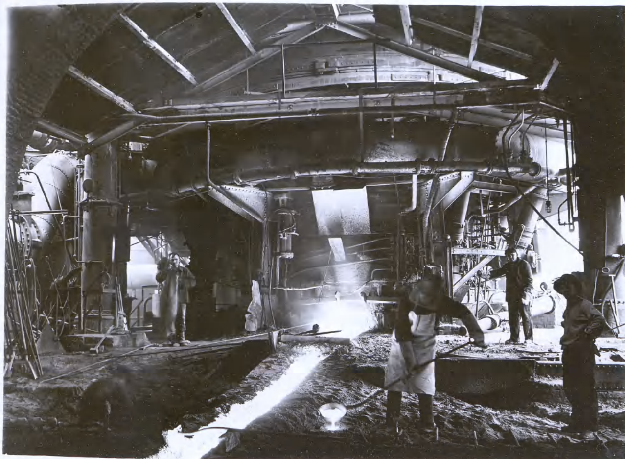
WIELKIE PIECE: Spust surówki wielkiego pieca i branie próby.
