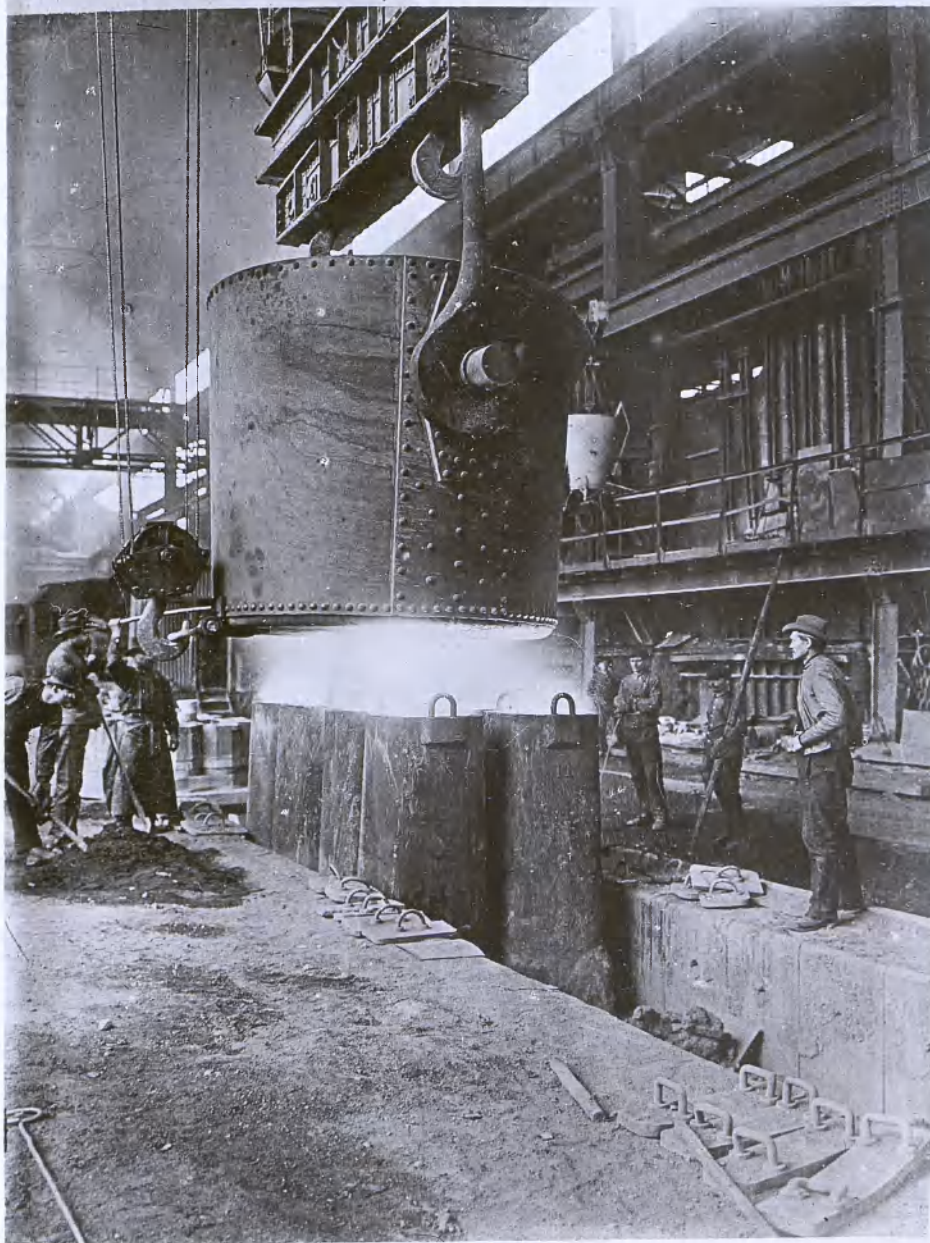
STALOWNIA: Hala odlewnicza - odlewanie wlewków.
