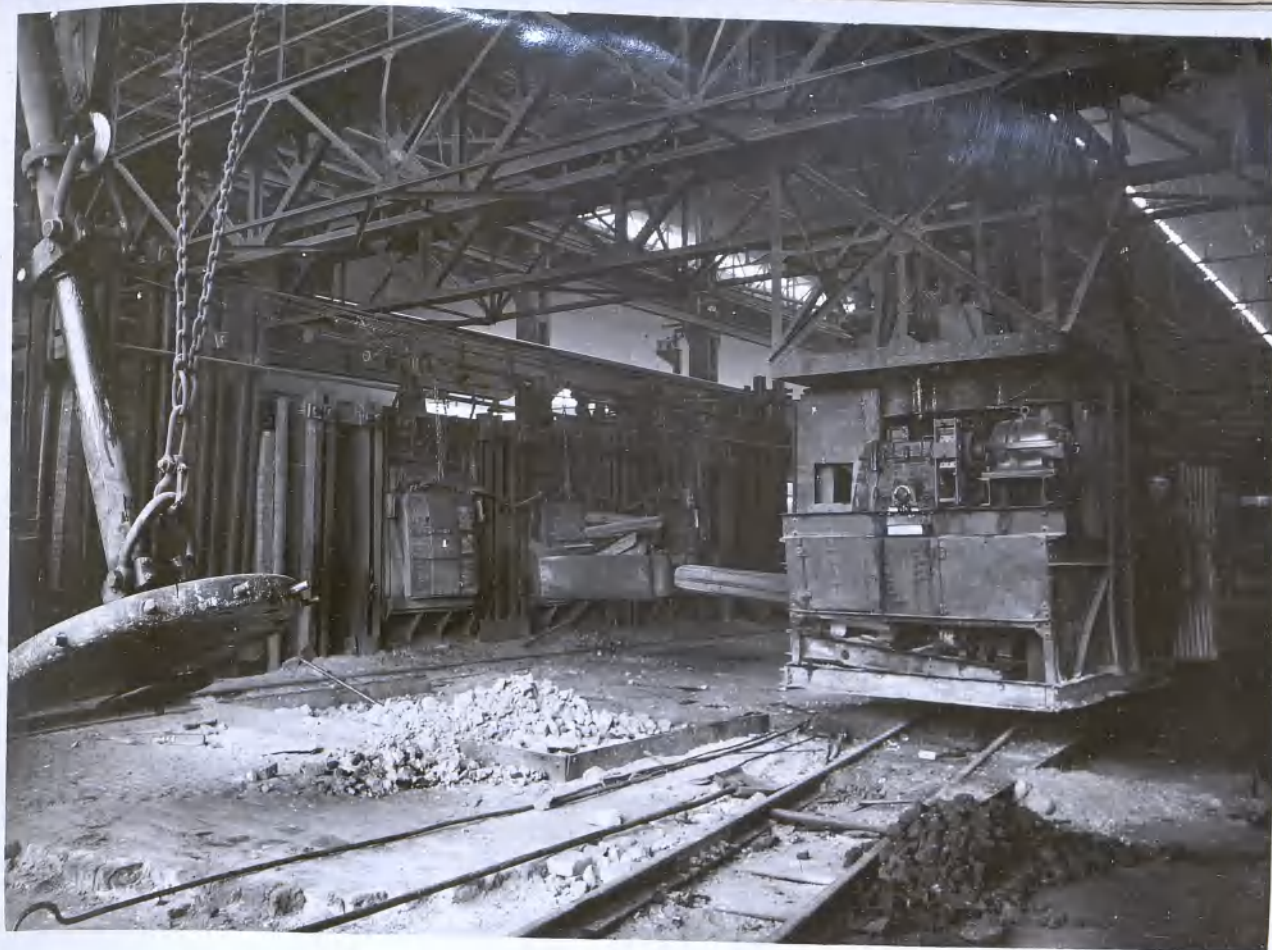
STALOWNIA: wsadzarka w ruchu na pomoście.
