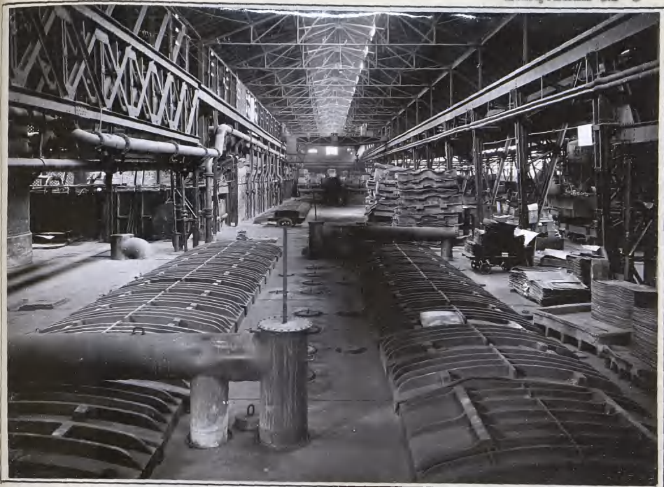
WALCOWNIA BLACHY CIENKIEJ: Wyżarzaki skrzyniowe.
