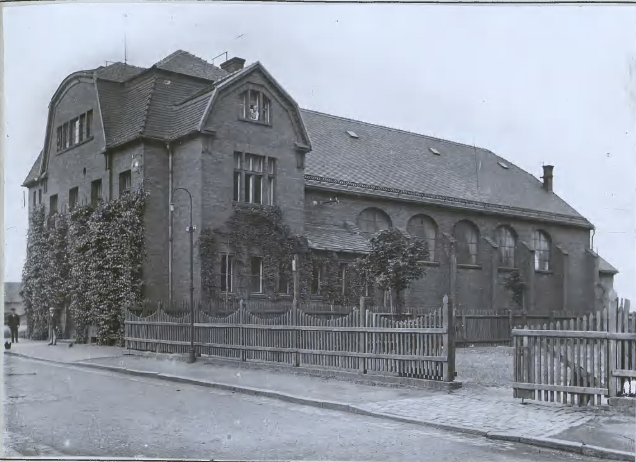
HUTA "POKÓJ": Budynek Sokoła.
