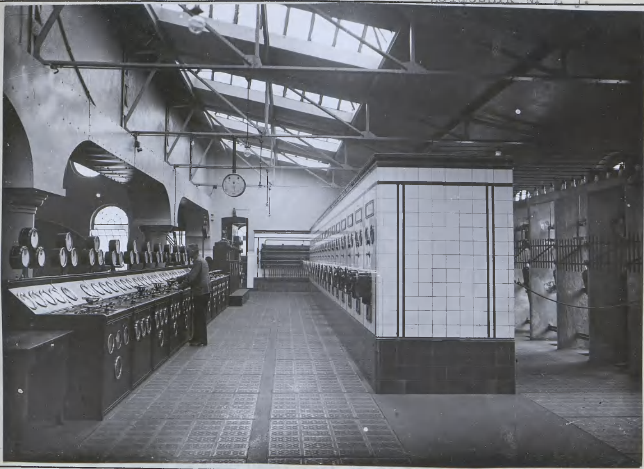
IMW - CENTRALA ELEKTRYCZNA: Rozdzielnia.
