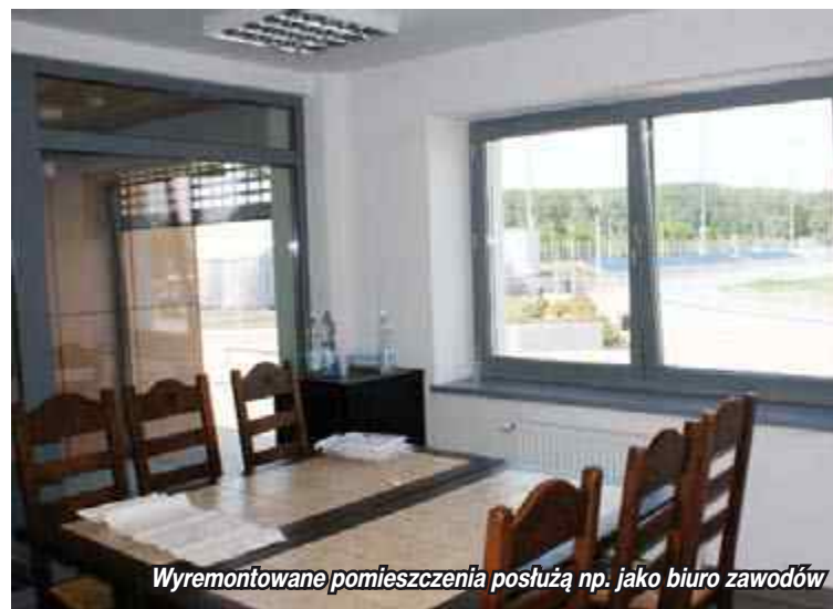
Wyremontowany budynek zaplecza stadionu
