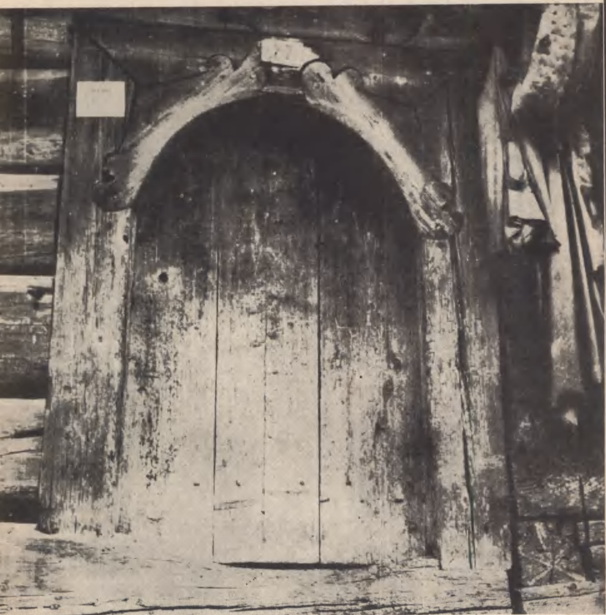
DRZWI WEJŚCIOWE W BUKOWCU, nr 77 — Fot. Daniel Kadłubiec
