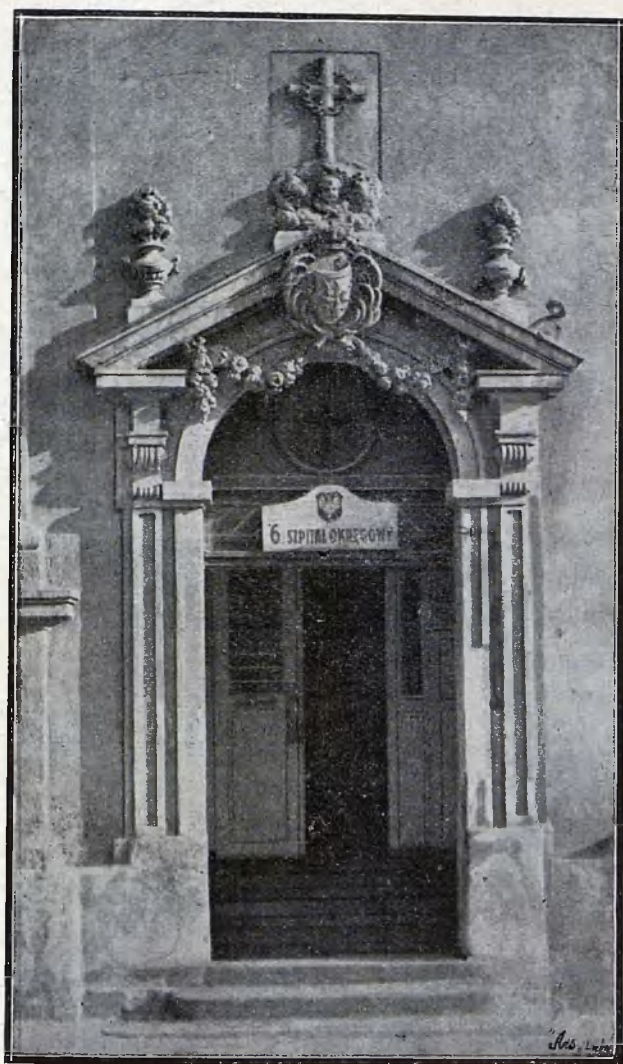
Odrzwia bramy wchodowej dawnego klasztoru OO. Bonifratrów przy ul. Łyczakowskiej l. 26.
