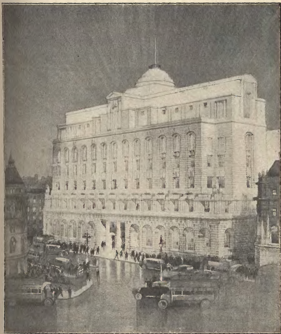
Wielki gmoch centrali Midland banku w Londynie, będący w budowie. Siedziba największego banku na świecie. Kapitał tego banku wynosi $ 11 milionów i posiada 1484 własnych oddziałów
