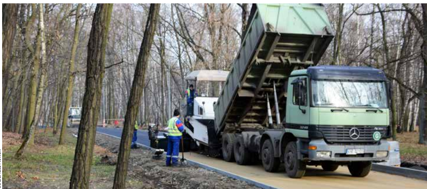
Ostatnie prace przy ul. Letniej.
