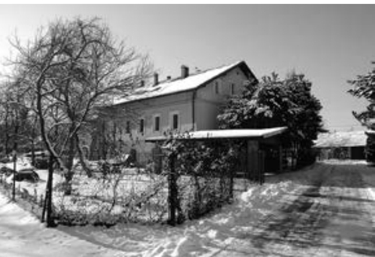
Zachowana część dawnej przędzalni Pieschów w Wapienicy, ul. Kopytko 63 📷 Wiesław Dziubek
