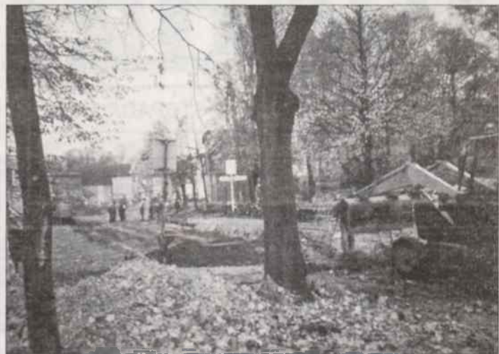
Trwają prace związane z budową kanalizacji sanitarnej
