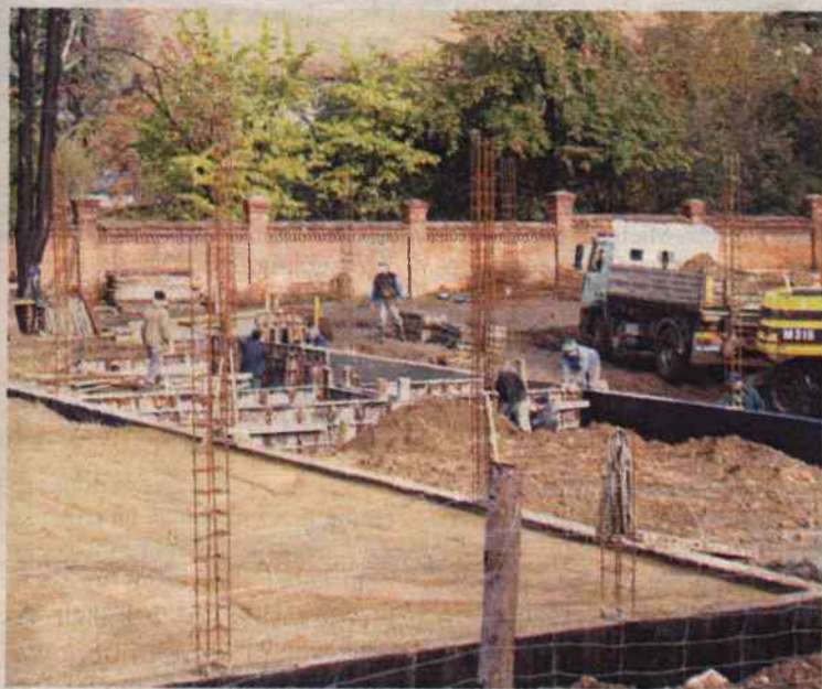
Budowa sklepu trwa na dobre, zobaczymy jak wpłynie to na ruch w okolicach mostu Bema
