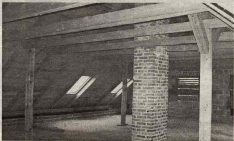
Tak prezentuje się dach po remoncie.
