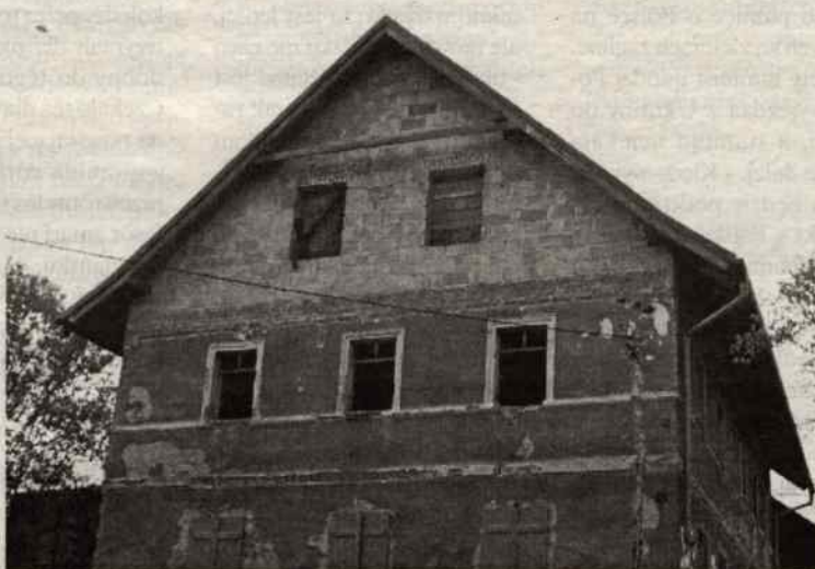
Nakładem NTSK wybudowano nowe stropy, dach, wstawiono okna na parterze. Remont trwa nadal.
