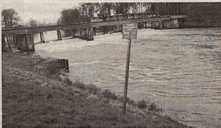
Tablica informująca o obrębie ochronnym przy jazie przy ul. Wyspiańskiego jest postawiona bezprawnie. Tam nie ma w/w obrębu.
