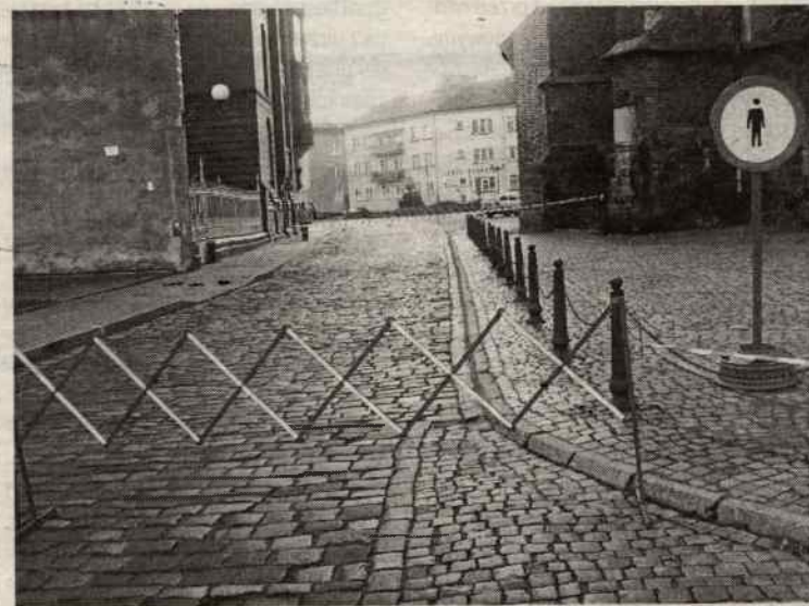
We wtorek zamknięto drogę obok katedry. Powodem były spadające dachówki
