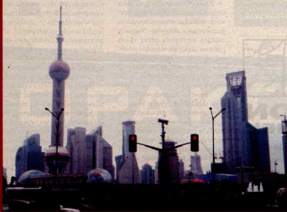
Szanghaj - Nowy Jork Wschodu. Po prawej trwa budowa jednego z najwyższych budynków świata (990 metrów)
