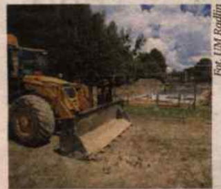
Tężnia solankowa jest już w budowie. Powstanie przy ulicy Wypandów.
