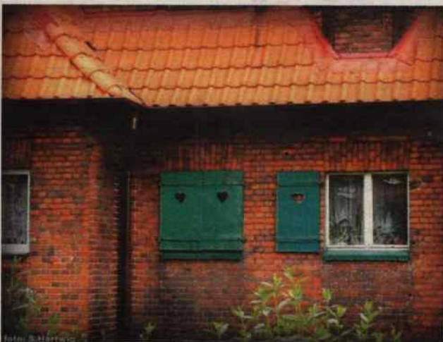
Charakterystyczne zielone okiennice z sercem zniknęły z radlińskiego osiedla kilka lat temu. Władze miasta dbają jednak o to, by prace renowacyjne wpływały na zachowanie klimatu tego miejsca.
