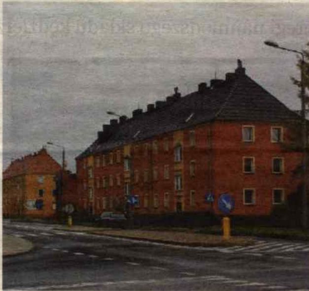
Drugi etap remontu ulicy Kozielskiej rozpocznie się przy markecie Carefour.
