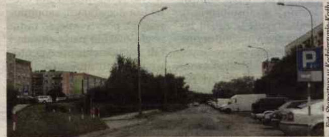
Po remoncie na ulicy Krzywoustego pojawi się m.in. ścieżka rowerowa.
