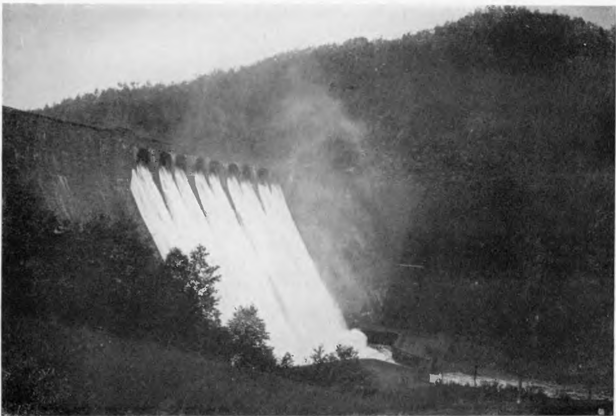
Abb. 4 b Talsperre bei Breitenhain. / Erbaut 1912–1917. / Stauraum 8 Millionen cbm. / Des Stausees Oberfläche 51 ha; Länge 3,3 km. Länge der Sperrmauer 230 m. / Höhe der Sperrmauer vom Felsgrunde 44 m. / Breite am Felsgrunde 29 m. Im Kraftwerk ca. 1000 m unterhalb der Sperrmauer: 3 Turbinen — 2 \times 720 + 290 PS 1730 PS. / 3 Drehstrom-Erzeuger 2 \times 685 + 275 kVA 1645 kVA. / Durchschnittliche Jahresleistung: 4 Millionen Kilowattstunden.
