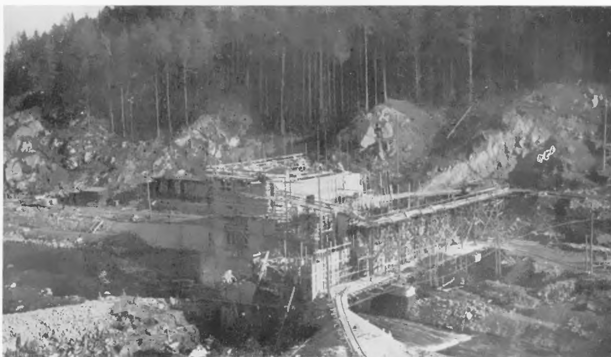
Abb. 5 b Stauanlage bei Boberröhrsdorf. / Erbaut 1924 -1925. / Stauraum 500 000 cbm. / Des Stausees Oberfläche 11 ha. / Länge der Wehrmauer mit Turbinenanlage ca. 90 m. / Gefälle 14,5 m. / Im Kraftwerk: 3 Turbinen 1800 + 1100 + 600 3500 PS. 3 Drehstrom-Erzeuger 1800 + 1100 + 600 — 3500 kVA. / Durchschnittliche Jahresleistung: 7 Millionen Kilowattstunden.
