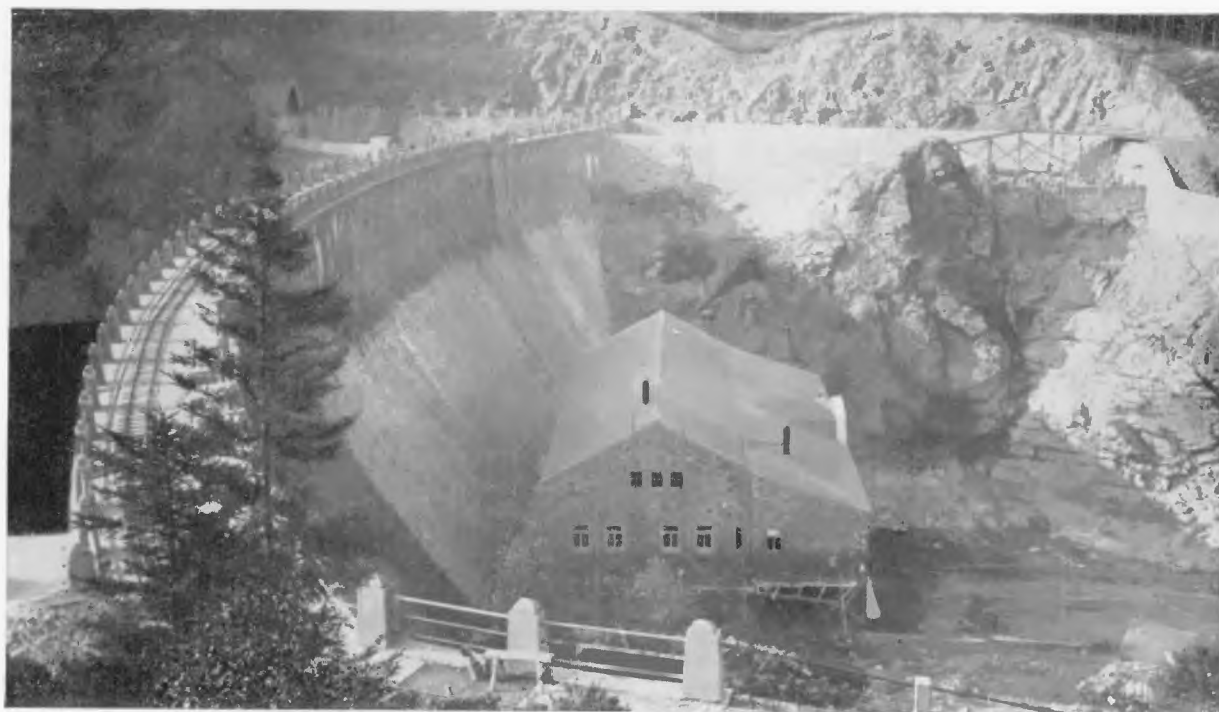
Abb. 3 b Talsperre bei Goldentraum. / Erbaut 1919-1924. / Stauraum 12 Millionen cbm. Des Stausees Oberfläche 125 ha; Länge 8,2 km Länge der Sperrmauer 168 m. / Höhe der Sperrmauer vom Felsgrunde 36 m. / Breite als Felsgrunde 27 m. / Im Kraftwerk am Fuße der Sperrmauer: 3 Turbinen — 2860 + 2150 + 1000 PS 6010 PS. / 3 Drehstrom-Erzeuger 2900 + 2100 + 1200 kVA 6200 kVA. Durchschnittliche Jahresleistung: 6 Millionen Kilowattstunden.
