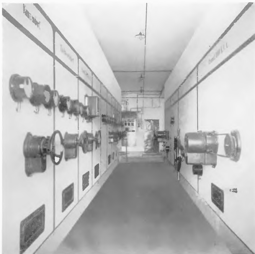
Bedienungsgang im Umspannwerk Münsterberg 40 000/15 000 Volt
