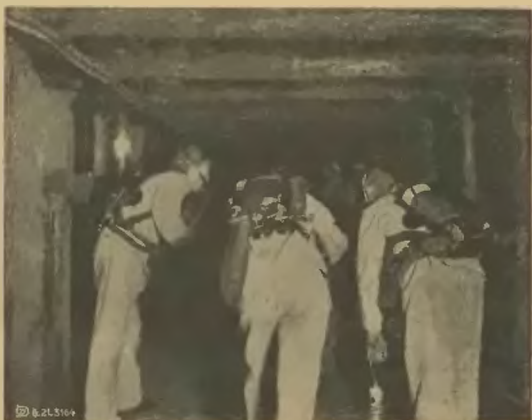
Abb. 32. In der Übungstrecke der Bergschule Bochum: Vorbringen in nicht atembaren Gasen mit Träger-Sauerstoffgeräten.
