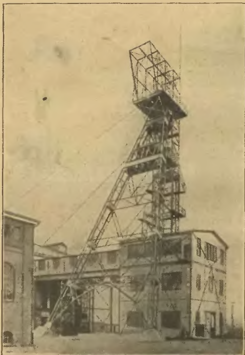
Abb. 18. Fördergerüst. Gesamthöhe 43,5 m. Erbaut von der Demag, Duisburg.
