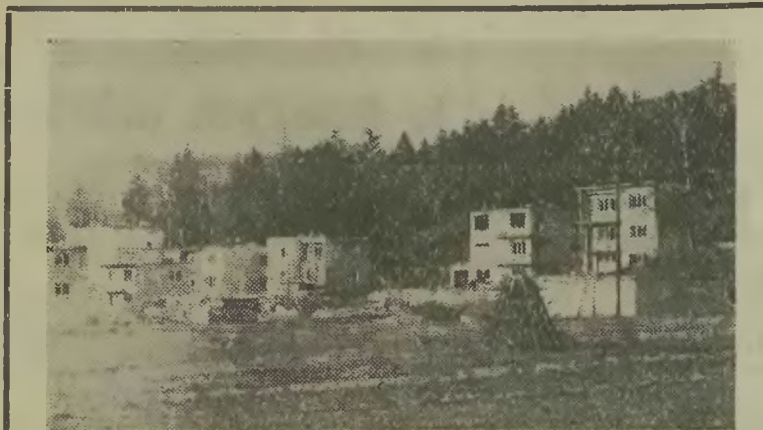
Budowa domków jednorodzinnych w Wlsie-Kopydle.
