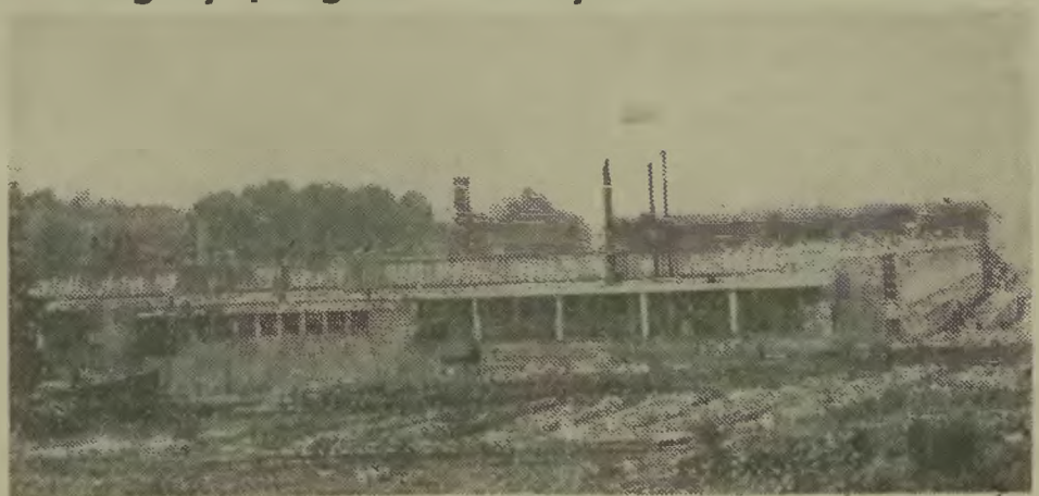
Nowa hala CWUCH
