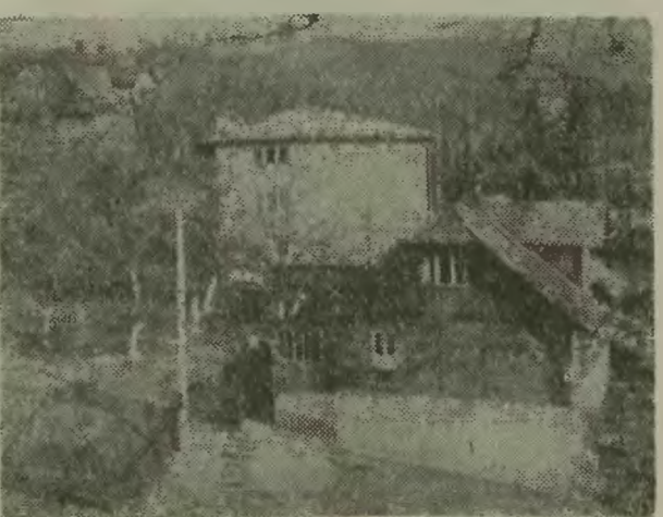
Dawne drewniane domki mieszkalne kryte gontami znikają z mapy górskiego krajobrazu. Zostępują je budynki murowane. ● Fot.: Stanisław Ceranowicz.
