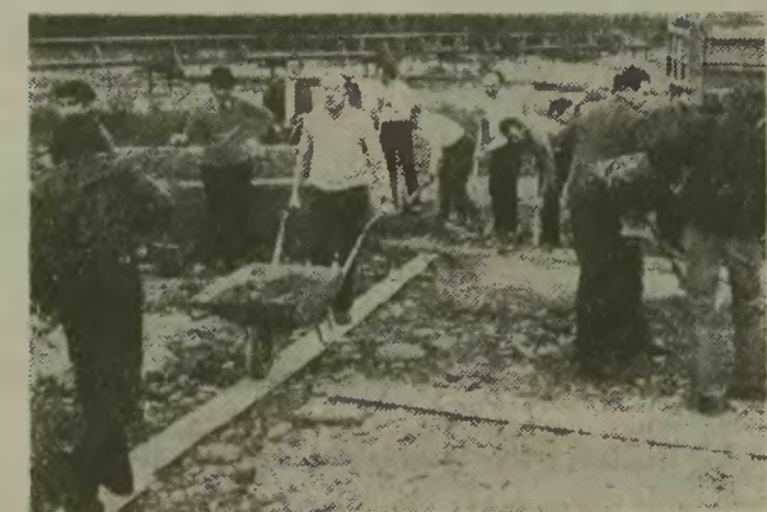
Współuczestnikami Czynu Partyjnego byli członkowie Stronnictwa Demokratycznego oraz rzemieślnicy naszego regionu, którzy pomagali przy budowie ośrodka wypoczynku świetlicznego w Brennej. ● Fot.: Tadeusz Kopoczek.
