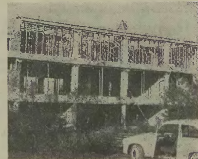
Sprawnie przebiega budowa nowoczesnej wylegarni karpia w Golyszu. ● Fot.: Paweł Czupryna
