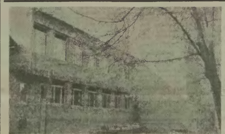
Druga część wybudowanej w stanie surowym centralnej kuchni szpitalnej. • Fot.: Tadeusz Kopoczek.
