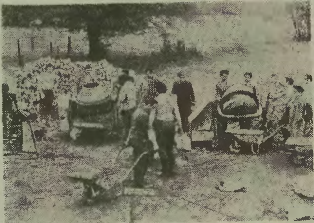
W Lipowcu pracowano przy budowie sali gimnastycznej. ● Fot.: Stanisław Czeranowicz.
