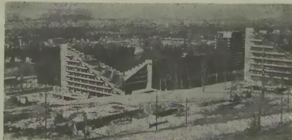
Widok ogólny wielkiego placu budowy Dzielnicy Lecznico-Rehabilitacyjnej w Ustroniu-Zawodziu. ● Fot.: Leszek Sikorowski.
