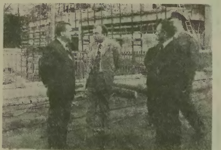
Zdzisław Grudzień na budowie obiektów dla służb paszportowych i celnych Mostu Wolności w Cieszyńsku. ● Fot.: J. Tadeusz Kopczek.
