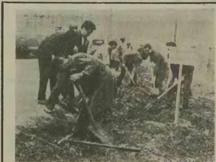
Pracownicy cieszyńskiego Oddziału PKS wyjechali natomiast do Wisły, gdzie pracowali przy budowie chodnika wzdłuż ulicy objazdowej w centrum uzdrowiska. ● Fot.: Stanisław Cerałowicz.
