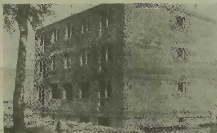
Trzeci już budynek mieszkalny dla członków RSP „Bucze” w Górkach Wielkich. W lipcu br. zamieszka w nim 9 rodzin spółdzielczych. W sąsiedztwie jego stanie w roku przyszłym kolejny blok dla 18 rodzin. ● Fot.: Paweł Czupryna.
