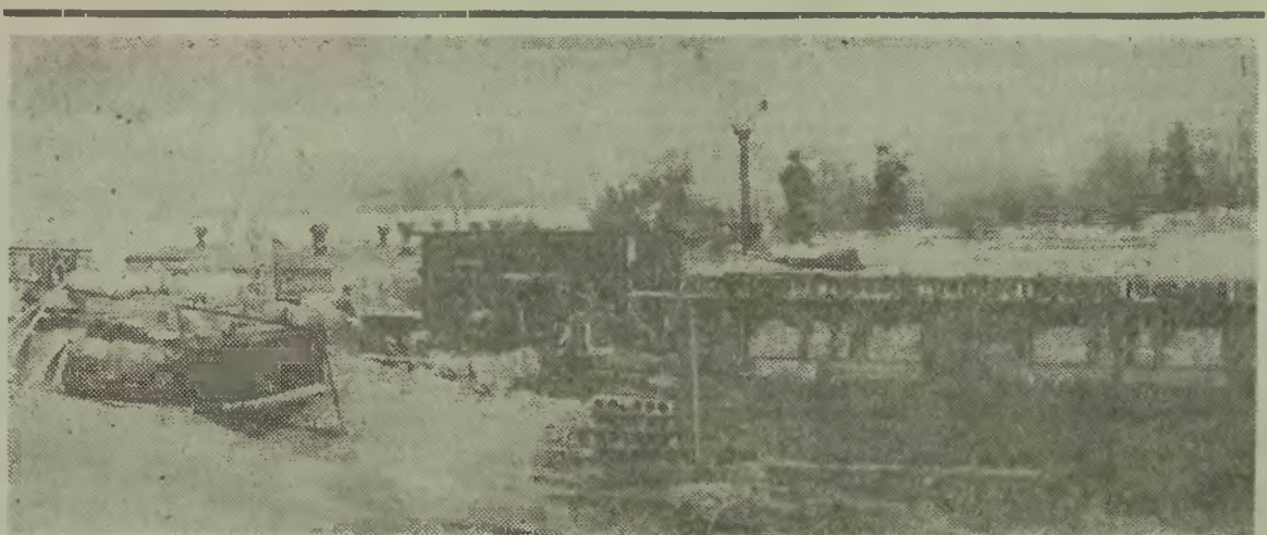
Teren Rolniczej Spółdzielni Produkcyjnej w Ogródzonej zamienil się w wielki plac budowy. • Fot.: Paweł Czupryna.
