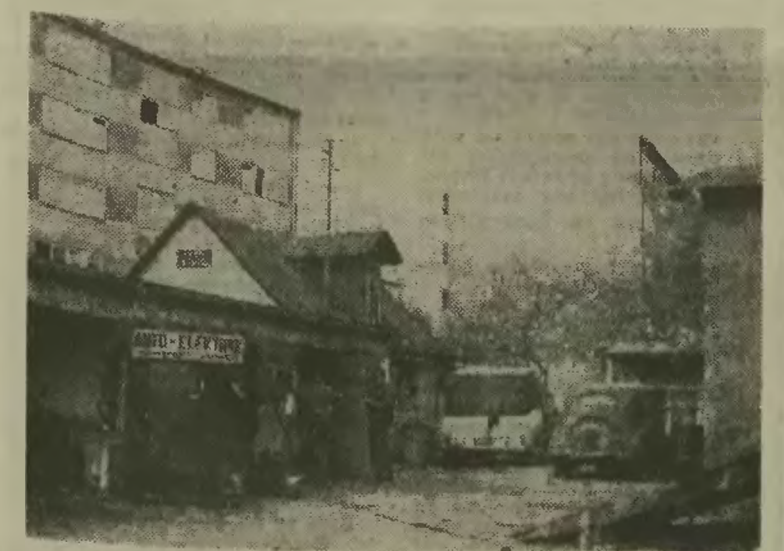
Szopy, przeznaczone do rozbiórki, zamienili się w warsztaty naprawy samochodów. Do nowoczesnego osiedla posują „jak pięć do oka”. Fot.: Tadeusz Kopoczek.
