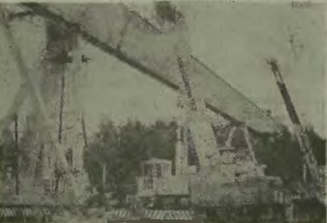
Jedna z faz montażu suwnicy bramowej opodal skoczowskiej elektrociepłowni. Do operacji sprowadzono największe dźwigi z Katowic, Rybnika i Jastrzębka. Fot.: Gaja.
