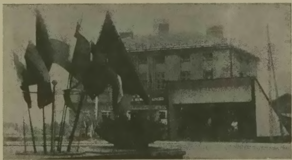
W centrum Golezowa powstał — zbudowany przy pomocy czynów społecznych — nowoczesny przystanek autobusowy.
