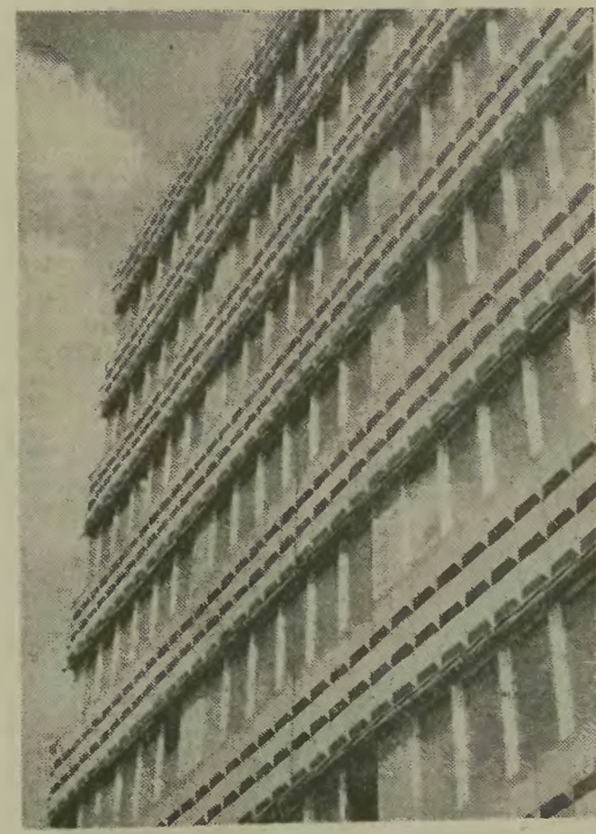
Efektowna fasada nowoczesnego obiektu przemysłowego. ● Fot.: Jonina Ciupek
