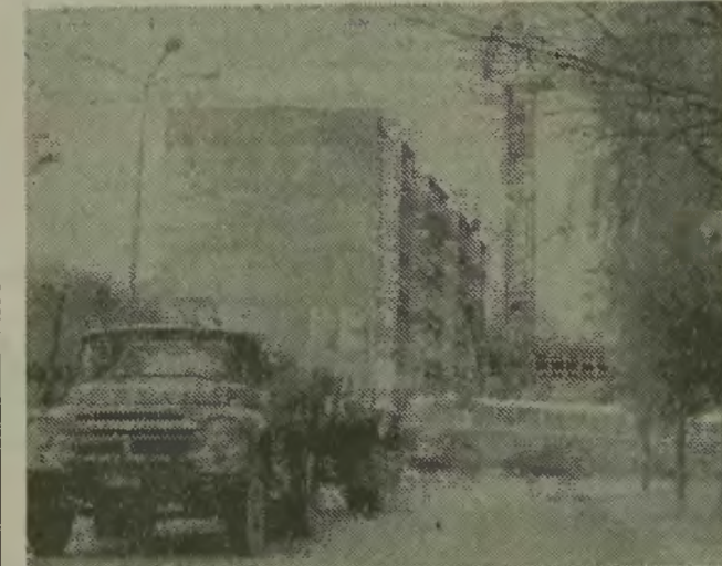
Dwa nowe bloki, które stanęły pod Kaplicówką, zapelnili lukę na istniejącym tam osiedlu. ● Fot.: Paweł Czupryna.
