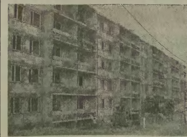
Równoległe do ul. Fryderyka Chopina, niejako na zapleczu domków jednorodzinnych kończy się monolit budowanego z płyt spółdzielczego bloku mieszkalnego. W Cieszynie przybędzie niebawem kilkadziesiąt nowych spółdzielczych mieszkań. • Fot.: Tadeusz Kopoczek.
