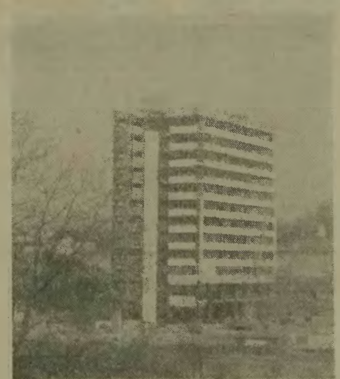
W panoramie Cieszyna dominuje od niedawna 11-piętrowy obiekt fabryczny ZKMPW „Elektrometal”, przy którym irwają roboty wykonawcze. • Fot.: Poweł Czupruna.
