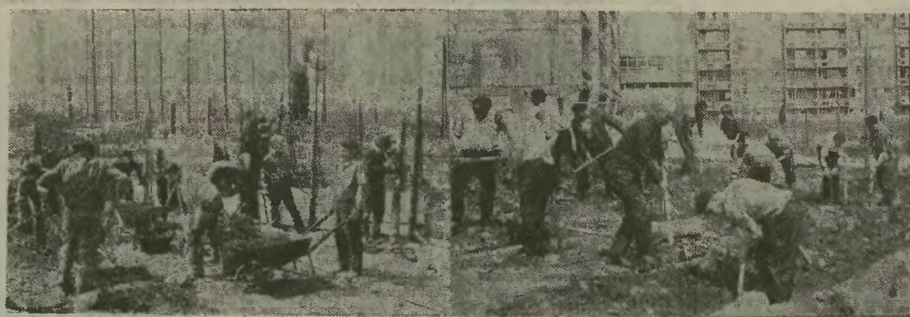
Z lewej: Budowa w czynie społecznym przedszkola w Nierodzimiu. ● Po prawej: Roboty przy szerakim deptaku wzdłuż ul. Objazdowej w Skoczowie. ● Zdjęcia: Tadeusz Kopoczek.
