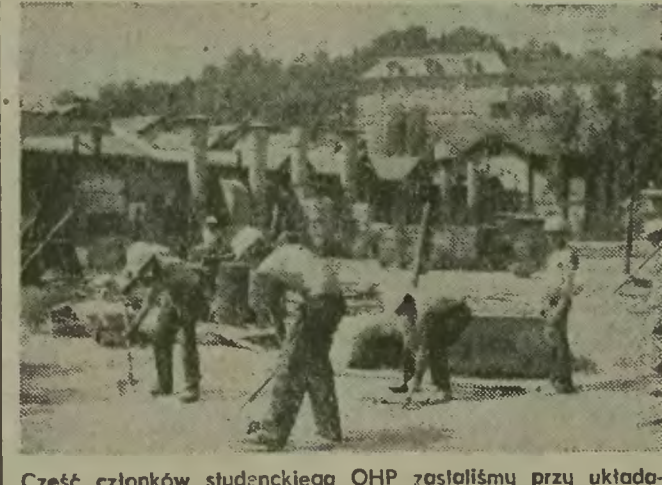
Cześć członków studentckiego OHP zastaliśmy przy układaniu nawierzchni przed punktowcem. ● Fot.: Tadeusz Kopczek.
