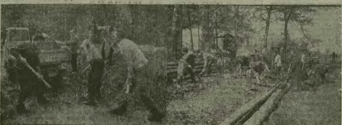
Z lewej: Pracownicy CELMY przy budowie deptaka wzdłuż al. Jana Łyska. ● Po prawej: Szereg podstawowych prac wykonano w przyszłym Ośrodku Harscarskim w Guldowach. ● Zdjęcia: Janina Ciupek.
