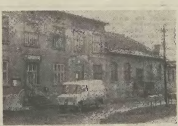
Okazały budynek przy ul. Fryszackiej na granicy Cieszyna i Marklowic jest własnością „Polifarbu”. Niestety poza sklepem spożywczym, zajmującym raptem dwa niewielkie pomieszczenia na parterze, reszta lokali jest niewykorzystana. • Fot.: Henryka Tomaszczyk
