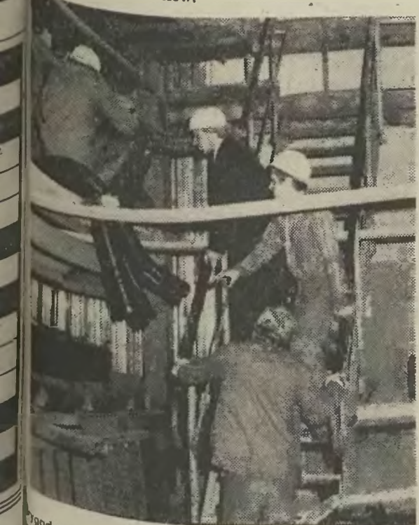
Pracownicy z katowickiego „Elektromontażu” przy instalacji 12 kotła wodnego. • Fot.: Henryka Tomaszczyk
