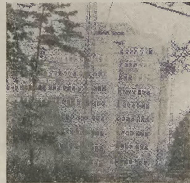
Równolegle z budową nowego pawilonu Szpitala Śląskiego odbywa się modernizacja i doposażanie istniejących. ● Fot.: Paweł Czupryna
