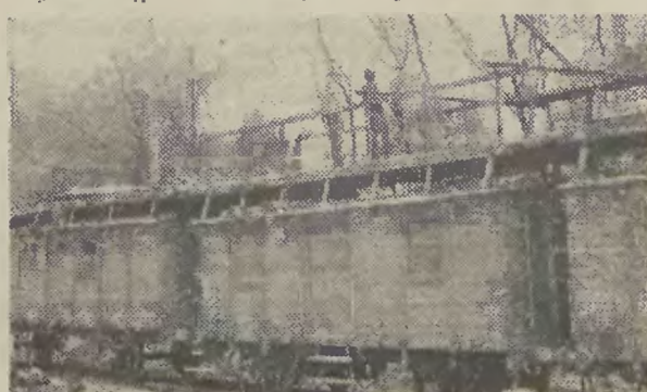
Sprawnie przebiega elektryfikacja linii kolejowej Bielska — Cieszyn w czym duża zasługa ekipy Wrocławskiego Przedsiębiorstwa Robót Kolejowych. • Fot.: Henryka Tomaszczyk.
