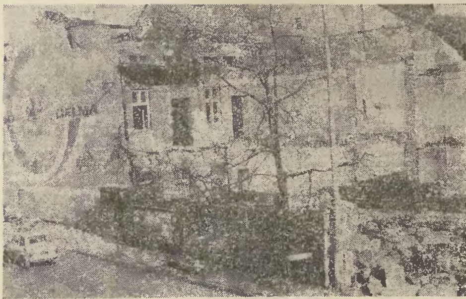
Na początku br. wyburzeniu uległ narożny dom przy ul. Wyższa Brama i pl. Wolności
