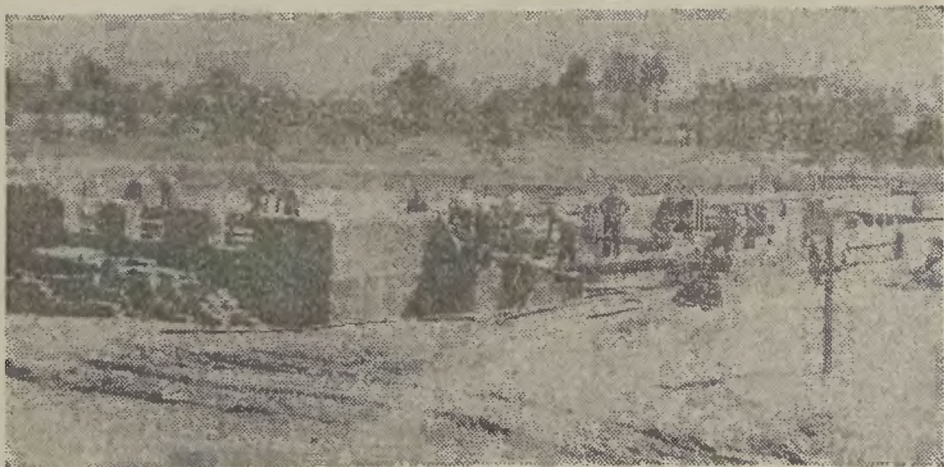
Budowa Szkoły „Tysiąclatki” w Strumieniu (1959 r.)
