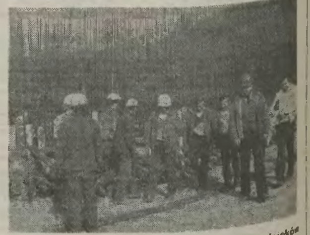
Gdy zespół kontrolny odwiedził oczyszczalnię ścieków trwały prace zbrojeniowe. • Fot.: Henryka Tomaszczyk.
