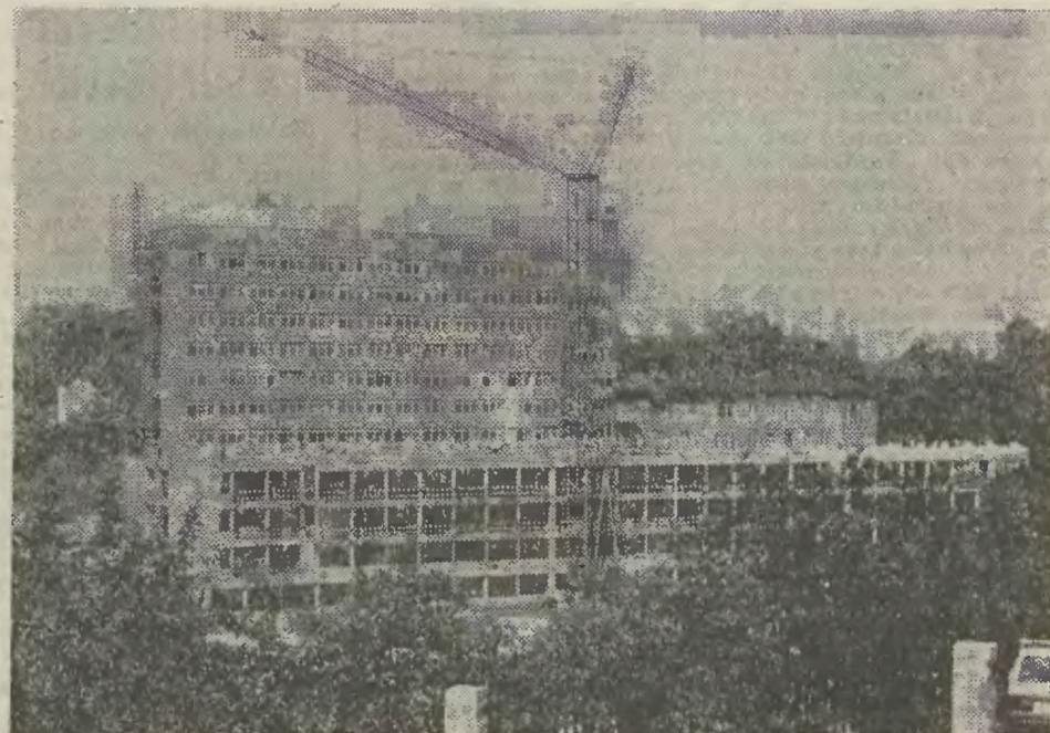
Wznoszone przez „Budopol” nowe obiekty Szpitala Śląskiego. • Fot.: Henryka Tomaszczuk
