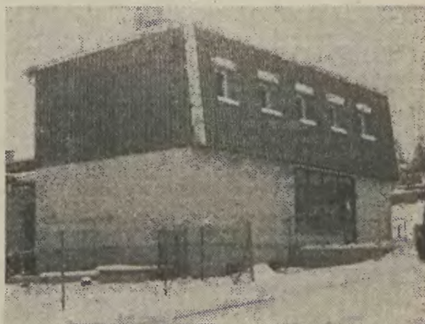
Nowo oddana do użytku zlewnia mleka i sklep firmowy w Wiśle. • Fot.: Henryka Tomaszczyk.
