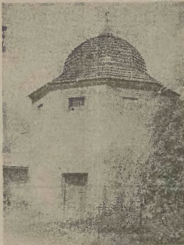
Ośmioboczny spichrz, kryty gontem w Dębówcu powstał na przełomie XVIII i XIX w. Obiekt ten służy do dziś miejscowej RSP „Zgoda”. • Fot.: Paweł Czupryna.
