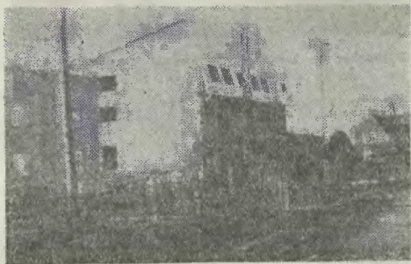
Strażnica znajduje się pod dachem. Trwają roboty wykończeniowe. • Fot.: Sebastian Raszka
