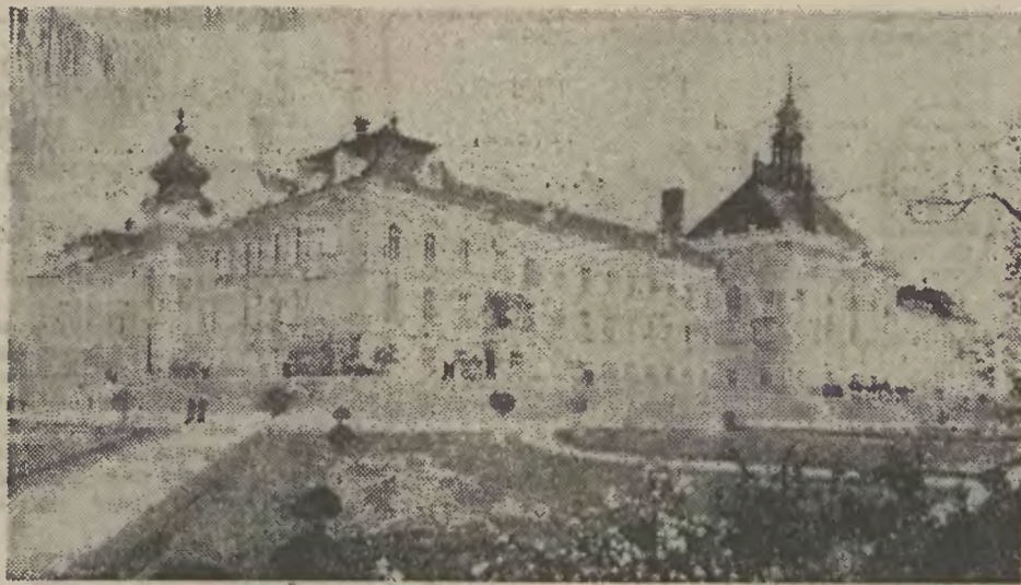
Z NASZEGO ARCHIWUM. Kłósztor ss. elżbietanek w Cieszyńsku mieścił się jeszcze z końcem ub. w. w. rynku, na miejscu, które zajmuje obecnie budynek Poczty i Urzędu Telekomunikacyjnego. W 1900 r. rozpoczęto budowę kompleksu obiektów ss. elżbietanek przy dzisiejszej ul. Armii Ludowej. Ukończono ją w połowie 1903 r. W okresie 2 lat i 6 miesięcy wzniesiono kościół, klasztor i szpital (obecnie Szpital nr 2 ZOZ). Projekt wykonał J. Müller, a budowę prowadził Józef Nosek z Cieszyńska • Zdjęcie z początku wieku. • Reprod. Henryko Tomaszewski.
