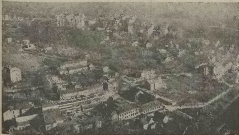
Widok z komina Elektrociepłowni na ul. Frysztaćką i osiedle Liburnia. • Fot.: Henryka Tomaszczuk.
