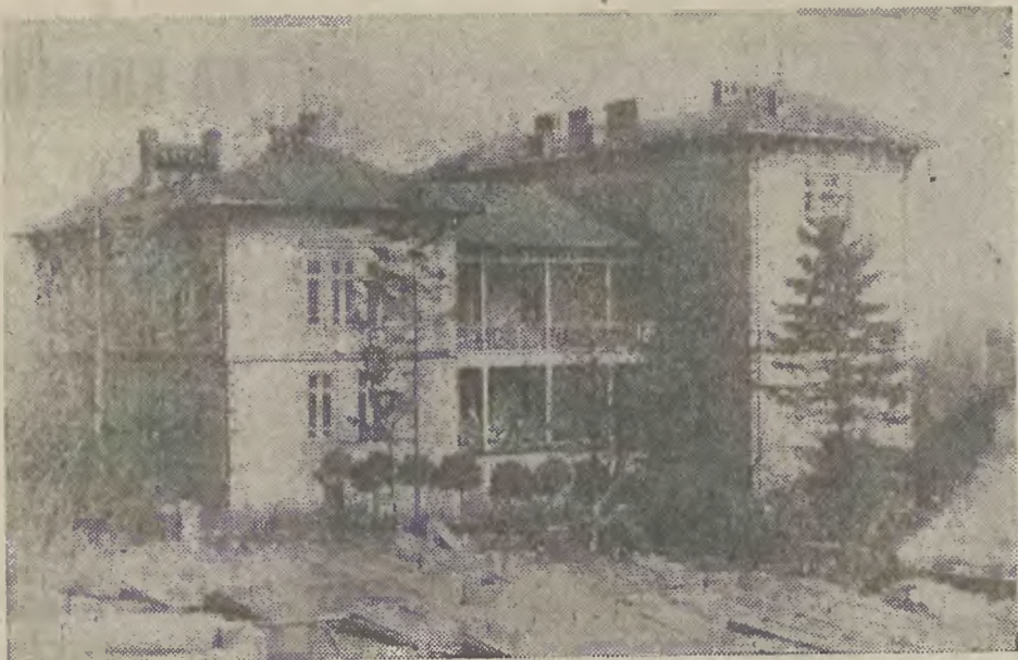
Z NASZEGO ARCHIWUM. Pawilon III Szpitala Śląskiego w Cieszynie z r. 1909. W latach 1963—1965 przeprowadzono jego nadbudowę wg projektu arch. Todeusza Koldra. Uzyskano dzięki temu nowoczesny blok operacyjny. W bież. dekadzie pawilon został objęty remontami i pracami modernizacyjnymi. Dokonano m. in. wymiany niektórych instalacji, doposażono również centralną sterylizatornię. Obiekt jest przeznaczony dla chirurgii ogólnej. Na parterze mieści się porodnia chirurgiczna, na I piętrze oddział I wraz z pododdziałem chirurgii dziecięcej kierowany przez Todeusza Jorosa a na II piętrze oddział II wraz z pododdziałem urologii, którego ordynatorem jest Roman Korbut. Pawilon dysponuje 120 łózkami i 3 salami operacyjnymi. • Zdjęcie z ok. 1920 r. Reprod. Henryka Tomaszczuk.
