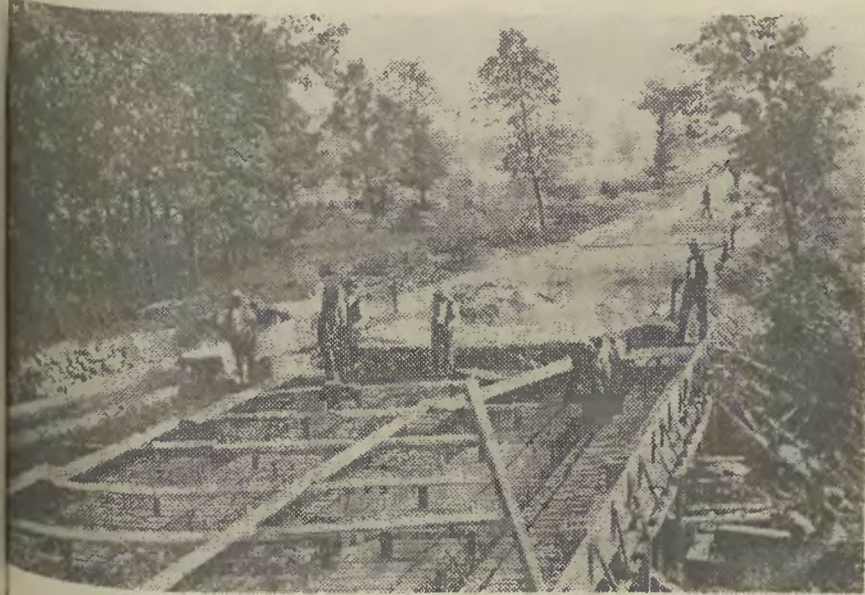
NASZEGO ARCHIWUM. Budowa żelbetowego mostu w Nierodzimiu, na drodze łączącej Wisłę ze Skoczowem. Zdjęcie z 1928 r. W tym samym roku wzniesiono poza tym innych żelbetowych mostów na tej drodze, a w Wiśle zbudowano żelbetowy most o długości 35 m. Rok wcześniej oddano do użytku linię kolejową do Ustronia, a w 4 lata później doprowadzono ją do Wisły Głębszej. ● Reprod. Henryka Tomaszczaka.
