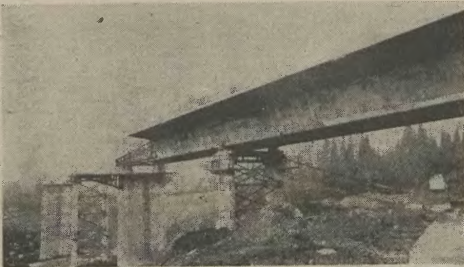
Przęsła mostu są odlewane, a następnie „nasuwane” na filary. Praca ta wymaga isticie zegarmistrzowskiej precyzji. ● Fot.: Henryk Tomaszczuk.
