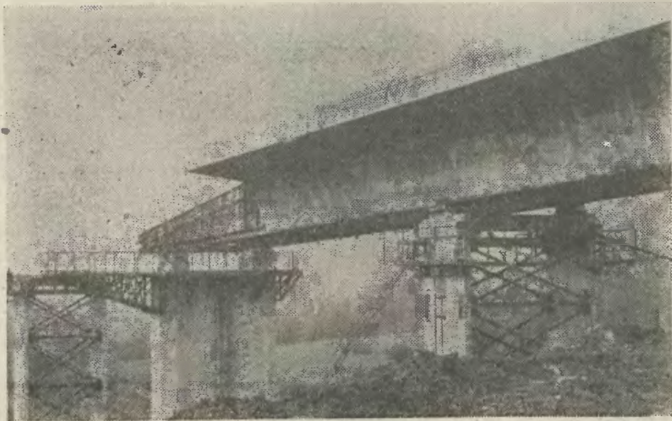
Iście zegarmistrzowskiej precyzji wymaga nasuwanie przęsła mostu granicznego, budowanego jednocześnie od ul. Łódzkiej w Cieszynie — Pastwiskach i od ul. Karwińskiej w Czeskim Cieszynie. • Wykonawcą jest warszawskie przedsiębiorstwo „Dromex”. • Fot.: Henryka Tomaszczyk
