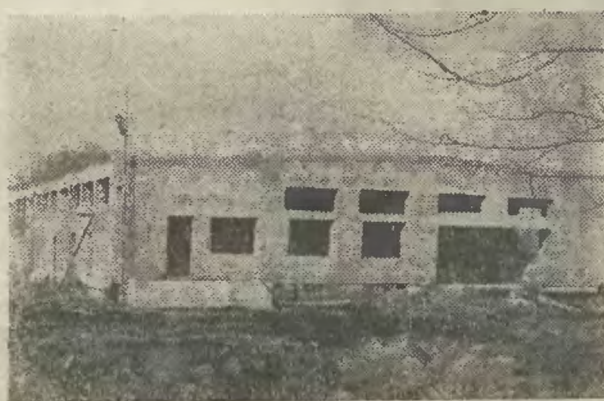
Budowana w Harbutowicach piekarnia dla Gminnej Spółdzielni w Skoczowie produkować będzie na 2 zmiany 7 t pieczywa. • Obiekt ma kosztować ponad 400 mln. zł i powstanie w ciągu 30 miesięcy. • Fot.: Paweł Czupryna.
