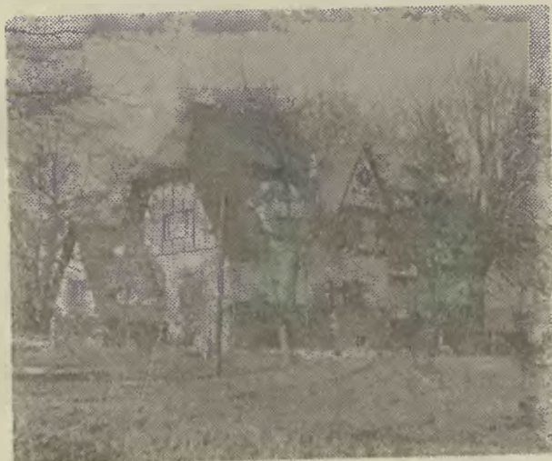
Budynek starego przedszkola w Końcycach Małych został zamieniony na mieszkania dla pracowników oświaty. Fot.: Poweł Czupryna
