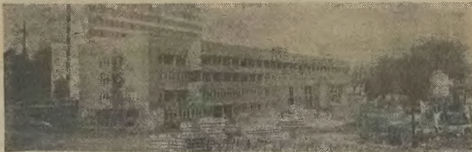
Pawilon diagnostyczno-zabiegowy Szpitala Śląskiego to na razie tylko mury, w których hula wiatr. Przekazanie obiektu wciąż oddala się w czasie... ● Fot.: Henryko Tomaszczyk.
