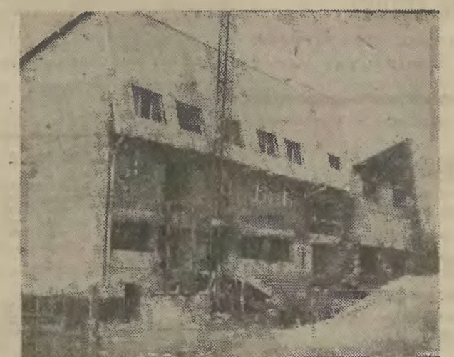
W Mniechu budowana jest remiza strażacka, jedna z najważniejszych w regionie. W obiekcie znajdzie się także sala wraz z zapleczem i sklep Gminnej Spółdzielni. Przewodzone są roboty wewnętrzne budynku. • Fot.: Paweł Czupryna.
