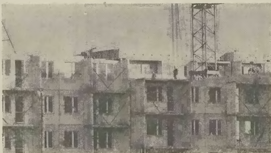
Przy ul. Gustawa Marcinka na osiedlu Podgórze w Cieszynie Spółdzielnia Mieszkaniowa „Cieszyńanka” wznosi 3 nowe bloki mieszkalne. • Fot.: Henryka Tomaszczyk.
