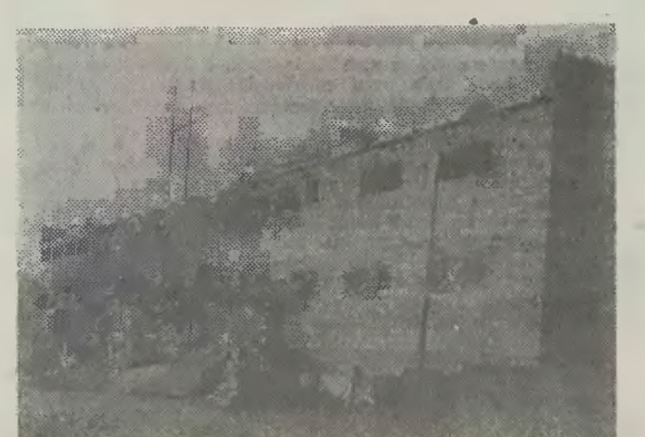
Pawilon handlowy budowany w centrum Zebrzydowice będzie największym sklepem GS-owskim w gminie. ● Fot.: Paweł Czupryna.
