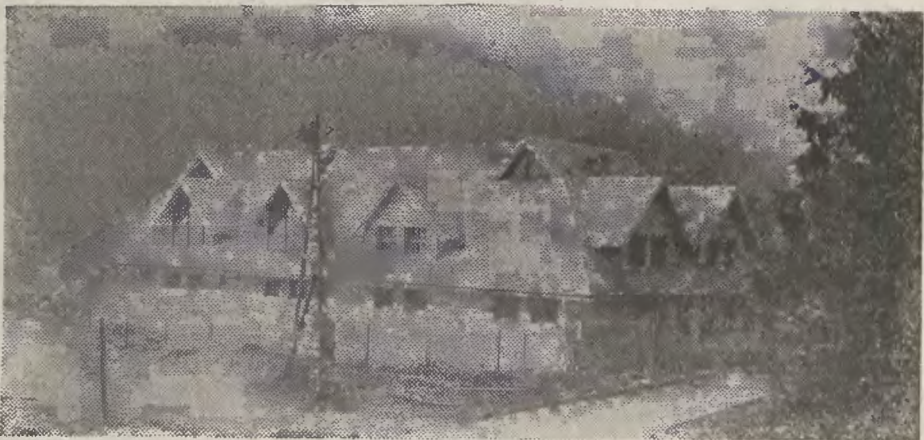
Ten stylowy obiekt w Brennej-Centrum niczym nie przypomina oczyszczalni ścieków. • Fot.: Paweł Czupryna.
