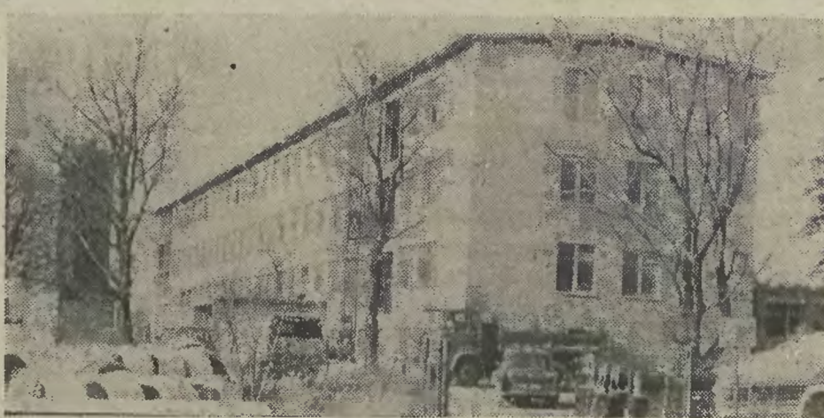
Nawa szkoła budowana jest w Dębówcu. Dotychczas inwestycja kosztowała ponad 250 mln złotych. W br. planuje się przeznaczyć środki na część mieszkaniową i salę gimnastyczną. • Fot.: Paweł Czupryna
