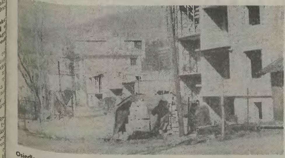
Osiedle mieszkaniowe przy ul. B. Prusa w Wiśle. W budowie znajdują się dwa bloki mieszkalne. Odbiór pierwszego z nich jest przewidziany na czerwiec • Fot.: Sebastian Raszka .
