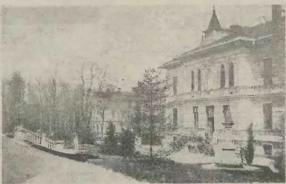
Z NASZEGO ARCHIWUM. Budynek administracyjny Szpitala Śląskiego w Cieszynie. Zdjęcie pochodzi sprzed I wojny światowej. W obiekcie tym mieściły się wówczas, oprócz biur, także mieszkania dla lekarzy, składnica leków i materiałów opatrunkowych, a w suterenie znajdowała się kuchnia pracująca dla potrzeb całego szpitala. Dyrektorem placówki był dr Herman Hinterstoisser (1861—1932), który zapewnił Szpitalowi Śląskiemu wysoki poziom opieki lekarsko-pielęgniarskiej. ● Reprod. Henryka Tomaszczak.
