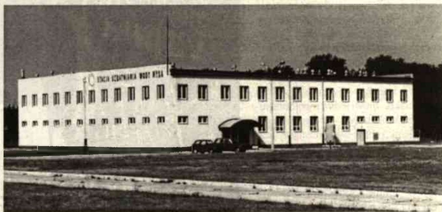
Stacja uzdatniania wody dla Nysy
