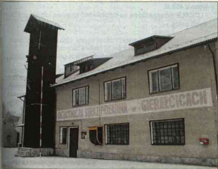
Siedziba straży pożarnej
