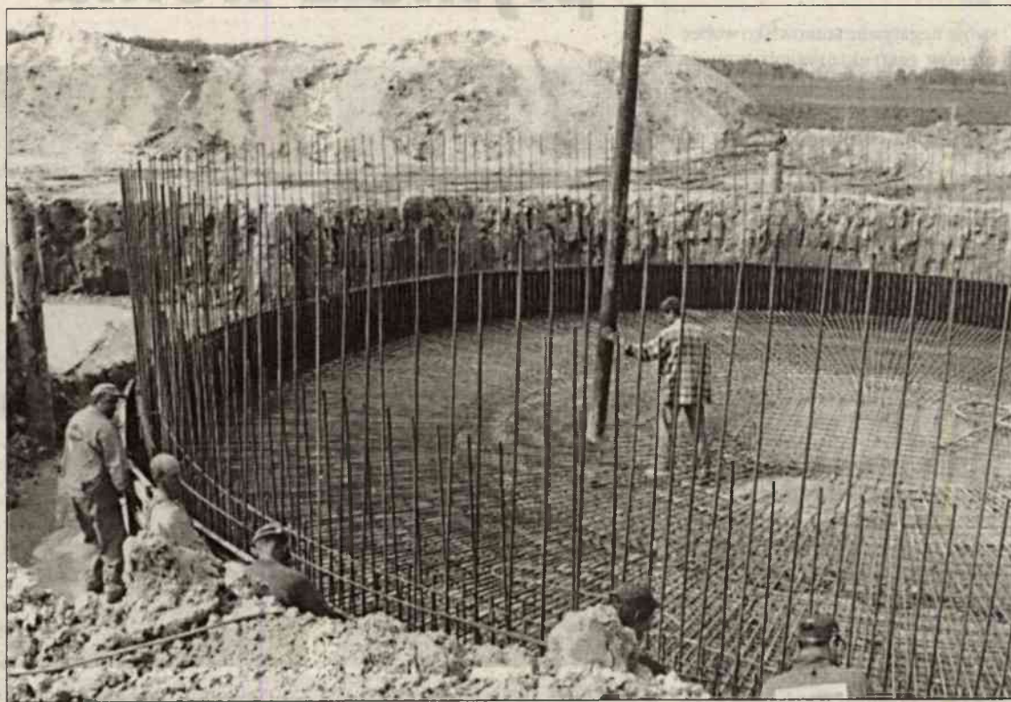
Jedna z inwestycji - oczyszczalnia ścieków
