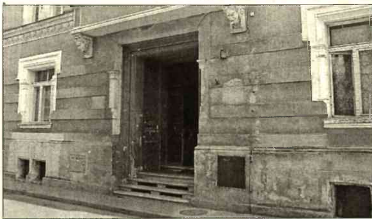
Ten budynek wymaga kapitalnego remontu
