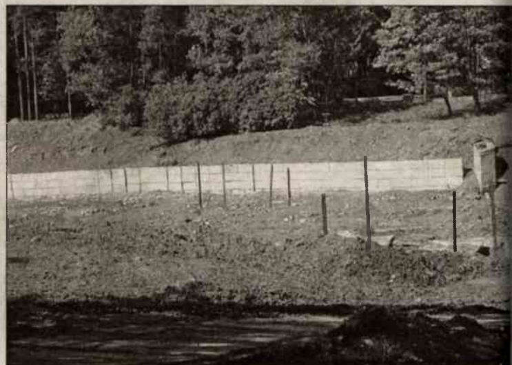
Na budowie nic się nie dzieje
