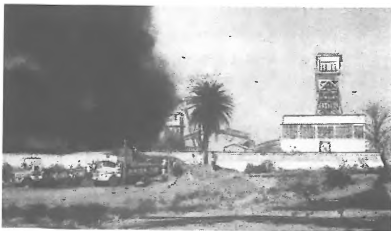
Dymy pożarowe wydobywające się z dyfuzora wentylatora na kop. Sudamdih
