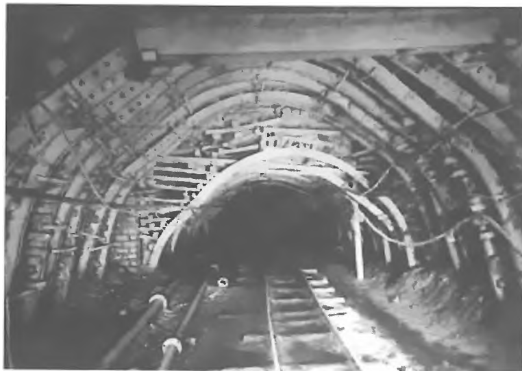
Kop. Jitpur – obudowa upadowej
