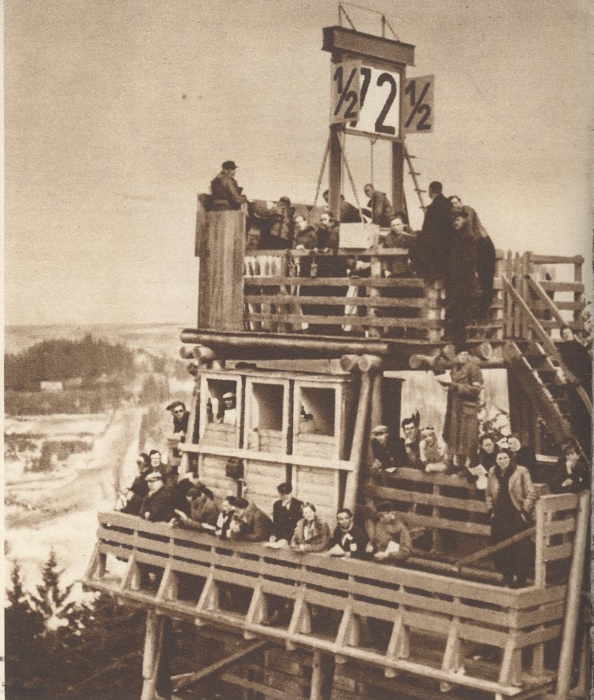
Fot. H. Schabenbeck. Umieszczona naprzeciw wieży sędziowskiej wieża sygnalizacyjna informowała o przebiegu konkursu.
