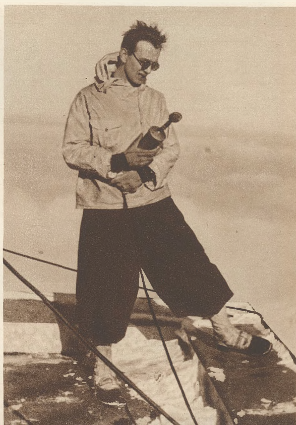
Próba radiowej instalacji na szczycie Kasprowego Wierchu przed biegiem zjazdowym.
