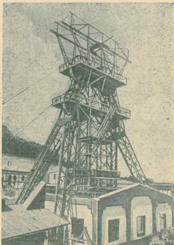
Rys. 5. Koła linowe na wieży nad sobą
