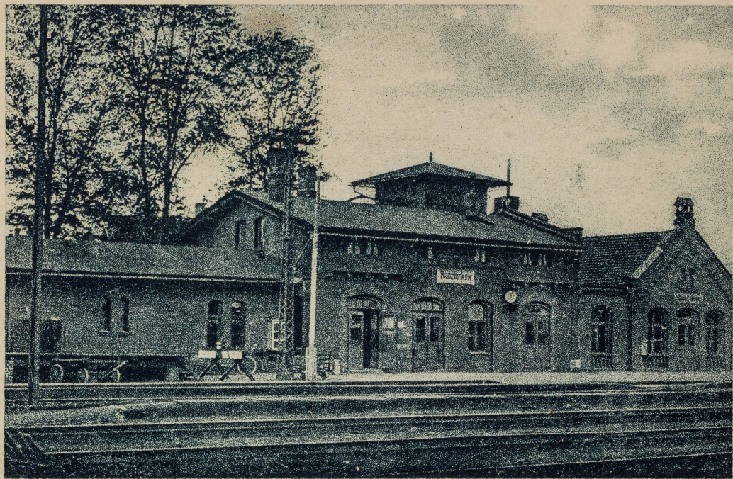
Dworzec kolejowy Radzionków
