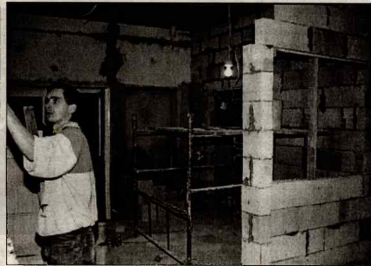
Remont ostatniej sali
