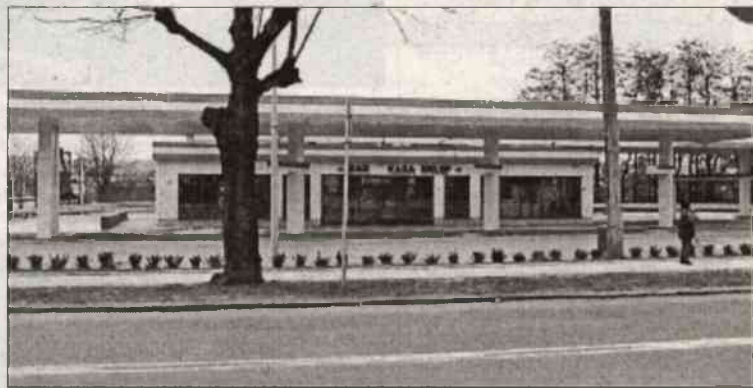
Gotowa stacja CPN
