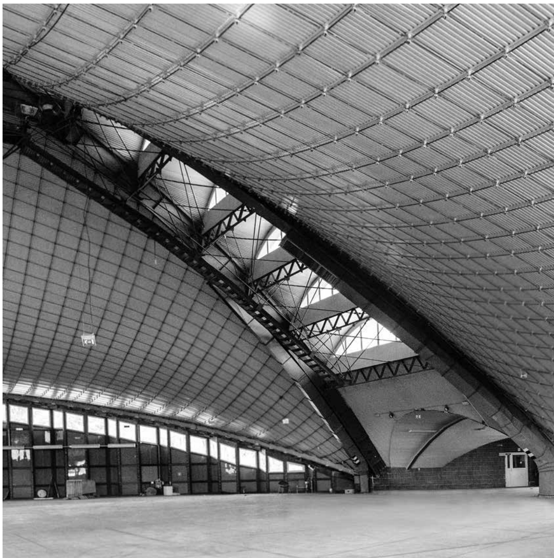
CHORZÓW, PARK ŚLĄSKI, HALA „KAPELUSZ”
