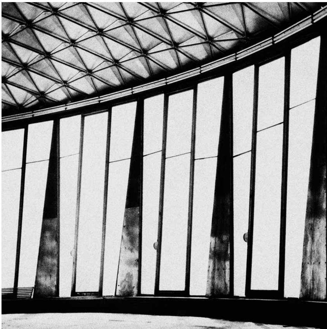
CHORZÓW, OŚRODEK POSTĘPU TECHNICZNEGO, PAWILON A
