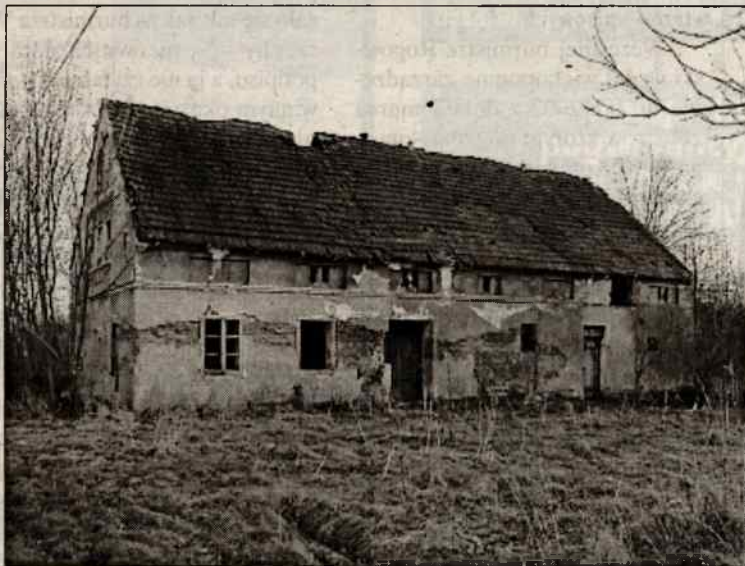
Wierzyć się nie chce, ale w tym domu mieszka człowiek. Ruina straszy swym wyglądem w Przydrożu Wielkim.
