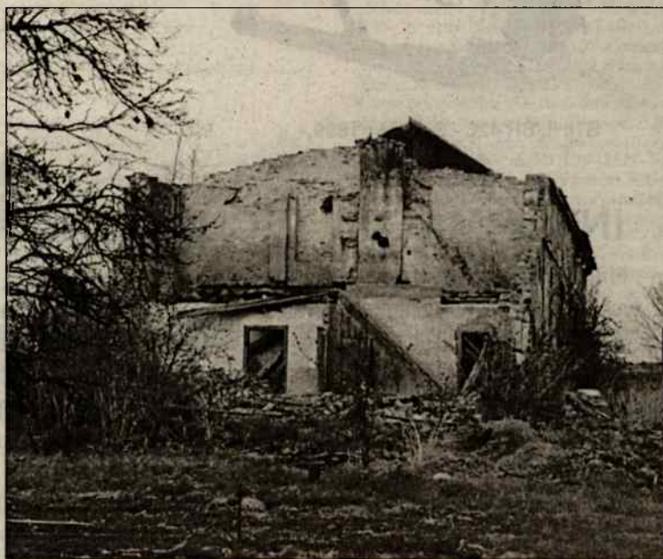
Rogi. Miejscowość o której mówi się, że jest czysta i gospodar- na. Wszystkie posesje oraz domy prawie jak nowe. Poza jednym wyjątkiem, który widoczny jest na zdjęciu.
