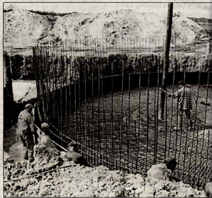
Zalewanie betonem zbiornika osadowego
