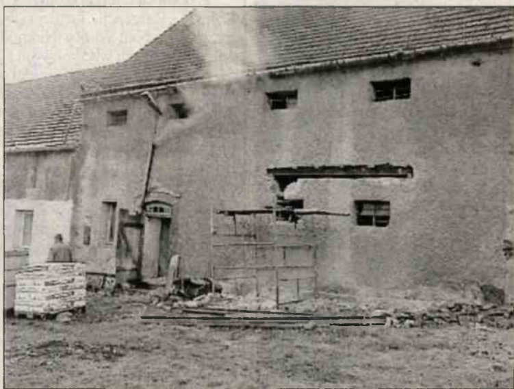
W tym miejscu ma być garaż remizy
