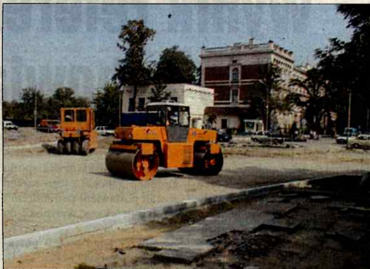
Ubijanie warstw konstrukcyjnych nowej nawierzchni
