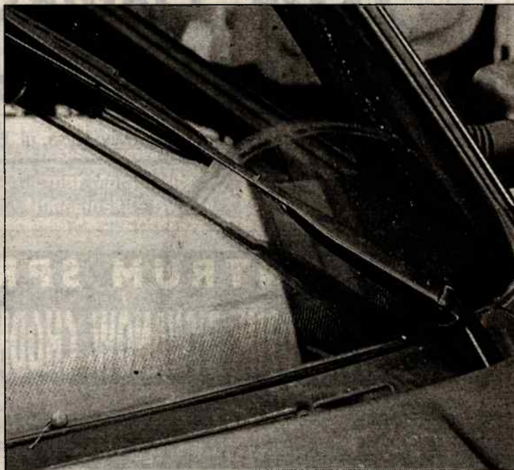
Uszkodzenie gumy w wycieraczce może spowodować defekt szyby
