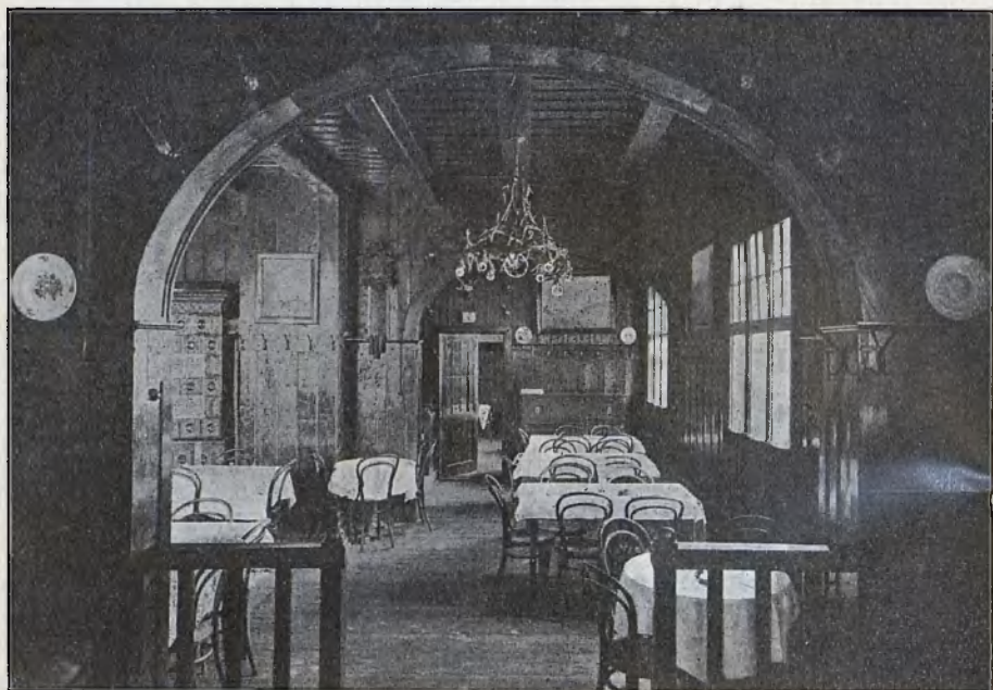
Mag-Schretterhaus, Teil des großen Speisesaales
